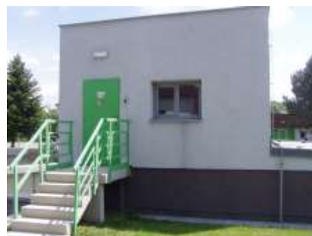
Čerpací stanice vratného kalu
