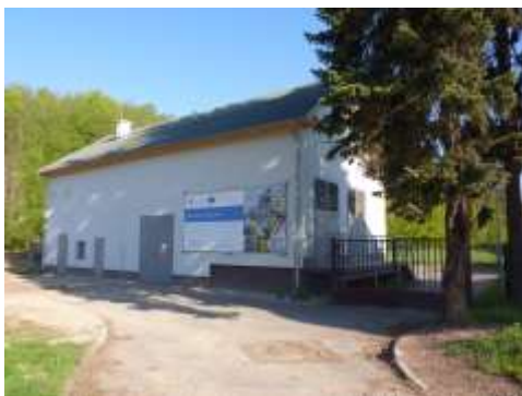
Vstupní čerpací stanice v ul. Nádražní
